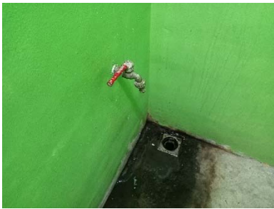
ก๊อกน้ำและท่อระบายน้ำในห้องพักมูลฝอยประจำชั้น การระบายอากาศในห้องพักมูลฝอยประจำชั้น
