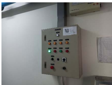
ตู้ควบคุม Transfer Pump
