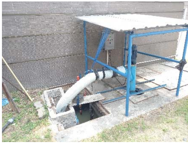
เครื่องสูบน้ำของระบบระบายน้ำ
