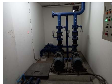
ถังเก็บน้ำชั้นใต้ดิน และ Transfer Pump
